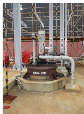
รูปที่ 3-9 บ่อพักน้ำ (Oily Water Tank)
