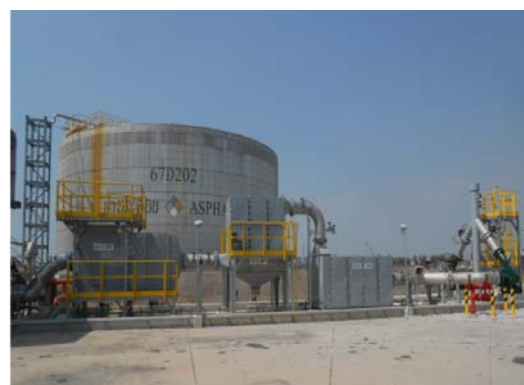
รูปที่ 3-5 ระบบควบคุมไอระเหยจากท่อระบาย ของถังเก็บกักขางมะตอย
