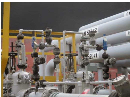
รูปที่ 3-27 วาล์วนิรภัยของระบบท่อขนส่ง
