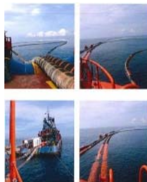
รูปที่ 3-34 การล้างทำความสะอาดท่อน้ำมัน
