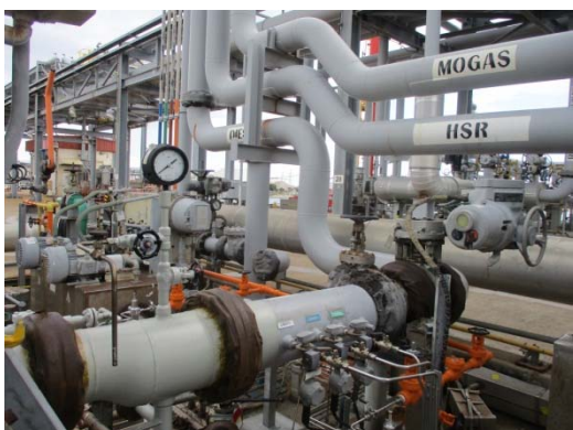
รูปที่ 3-29 Emergency Shut Off Valve ที่ Loading Arm
